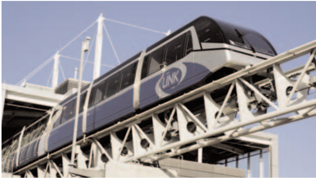
Vollautomatischer Flughafenterminal-Shuttlezug in Birmingham von Doppelmayr Cable Cars.
