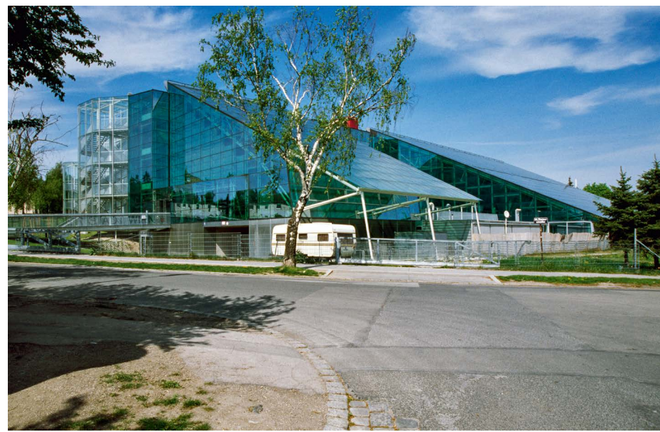
Die 1992–1994 von Helmut Richter erbaute ehemalige Informatikmittelschule am Kinkplatz in Wien-Penzing
