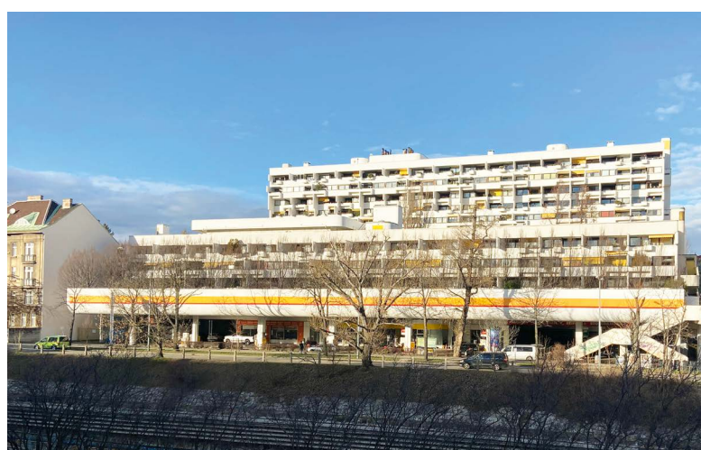
Diese Wohnanlage an der Hadikgasse von Harry Glück ist ein herausragendes Beispiel für das Wohngefühl der 1970er Jahre.
