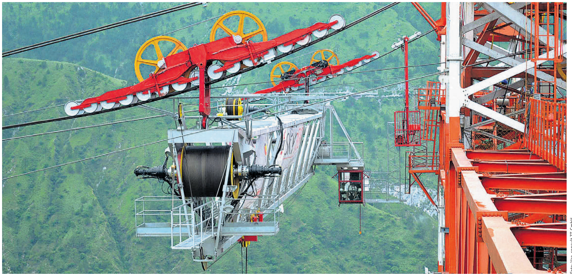
Der vom Wiener Ingenieurbüro VCE um Dipl.-Ing. Robert Schedler entwickelte Kabelkran für den Bau der höchsten Eisenbahnbrücke der Welt steht im Himalaja in Indien. Die Stahlkonstruktion hat eine Gesamtlänge von 1.350 Metern.
