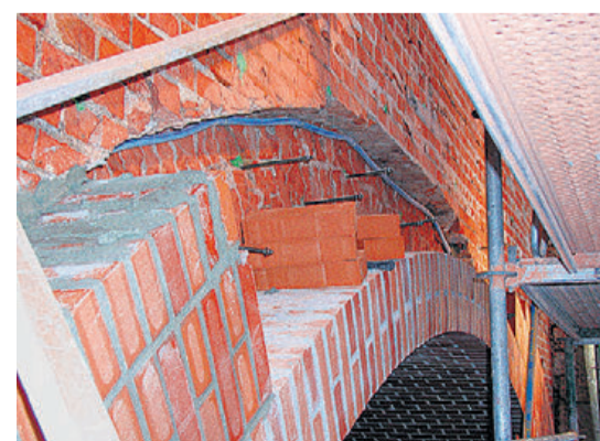
140 Jahre alte Aquädukte während des Betriebes zu sanieren war Neuland – bis jetzt.
