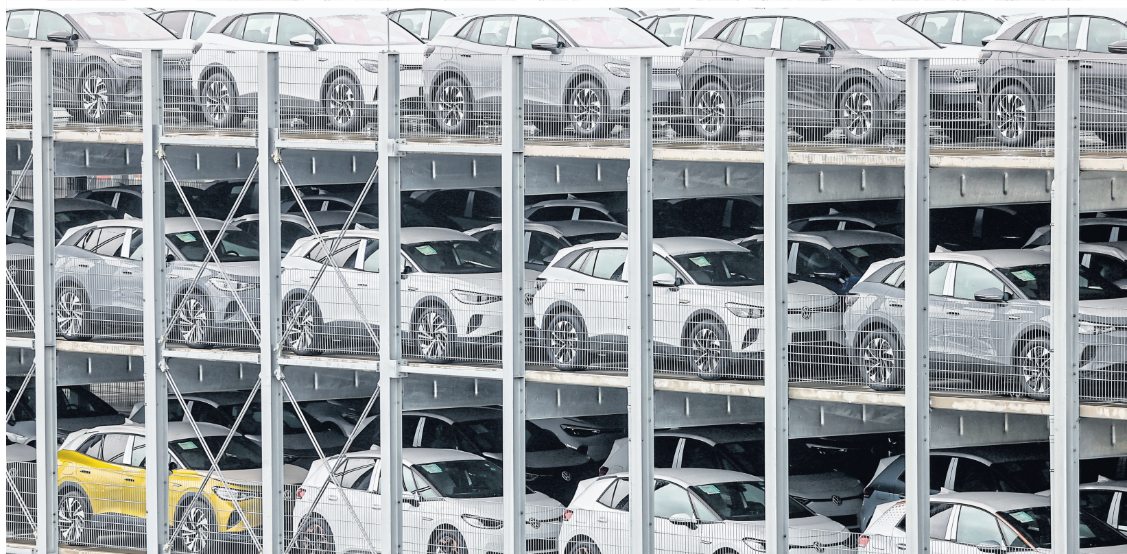
Elektroautos werden immer beliebter. Ihre Akkus bringen aber mehrere Hundert Kilogramm auf die Waage. Nicht alle Parkhäuser sind für diese Lasten ausgelegt
