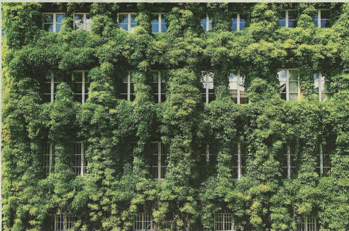
Fassadenbegrünung und andere Nachhaltigkeitsmaßnahmen fallen in Wien oft alten Vorschriften zum Opfer. [Getty Images/Alexander Spatar]
