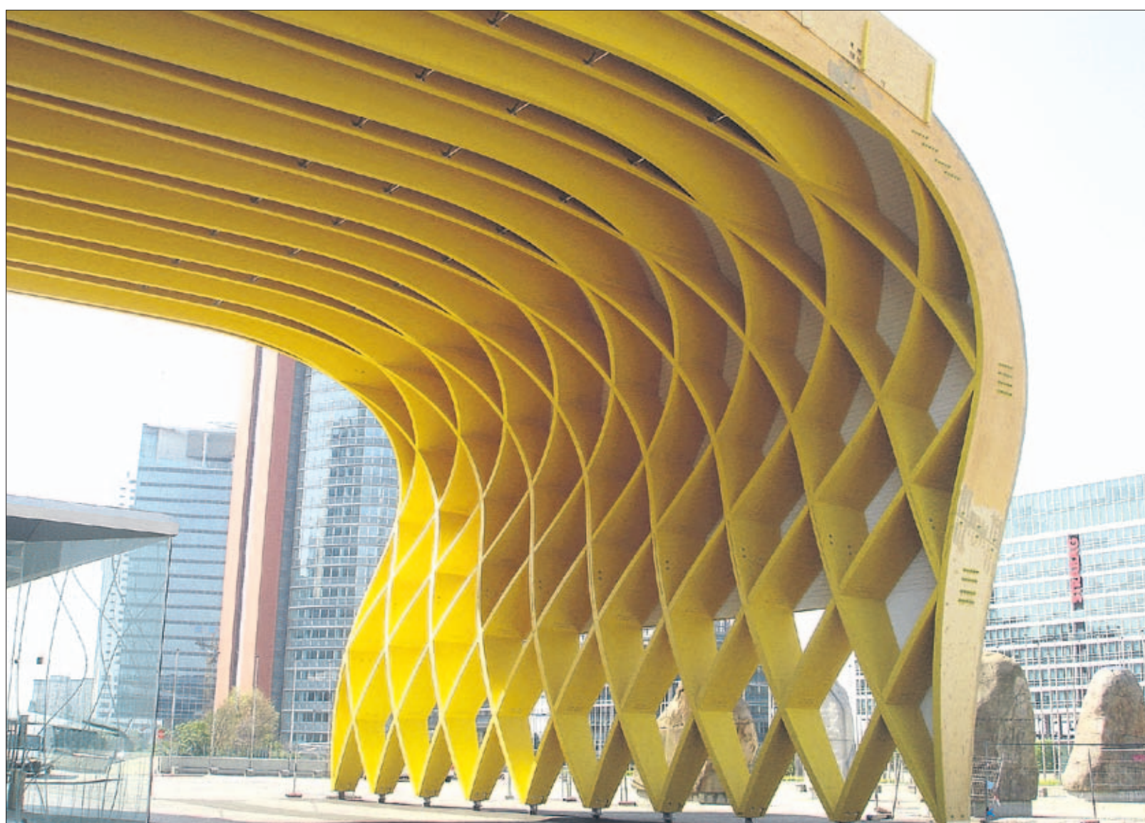
Der Preisträger des Wiener Ingenieurpreises Dipl.-Ing. Dr. techn. Richard Woschitz ist der Ingenieur der „Welle“ aus Holz, die eine gelungene Umplanung der ehemals in Stahl geplanten Konstruktion in Holz ist. Es ist dies eine erfolgreiche Zusammenarbeit des Bauingenieurs mit Architekt Christian Knechtl. Foto: C. Woschitz
