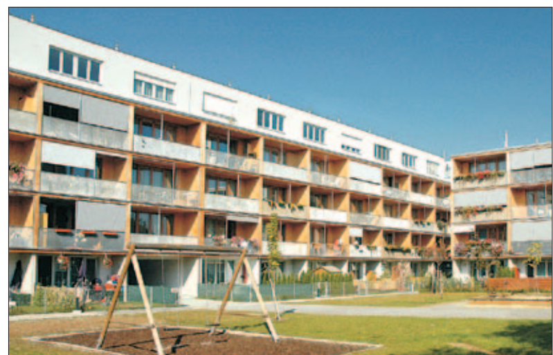
In der Wohnhausanlage Spöttlgasse wurden große und massive Holzbauteile eingesetzt. Neu war, dass die Wand- und Deckenteile vorgefertigt wurden, wodurch sich die Bauzeit extrem verkürzte.
