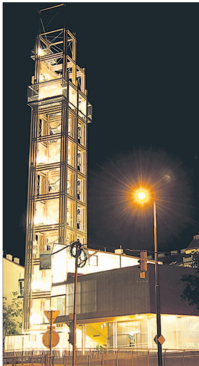
Der höchste begehbbare Holz-Aussichtsturm Europas ist 66,72 Meter hoch, hat eine Aussichtsplattform auf 40 Metern Höhe und besteht aus Fichten-Brettstichholz – geplant mit dem Architekturbüro RAHM aus Wien sowie Zmstr. Hans Matzinger.
