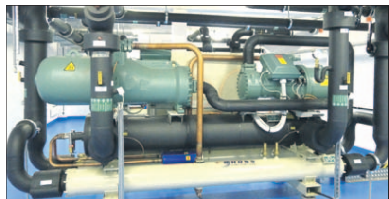
Foto: Wien Energie
