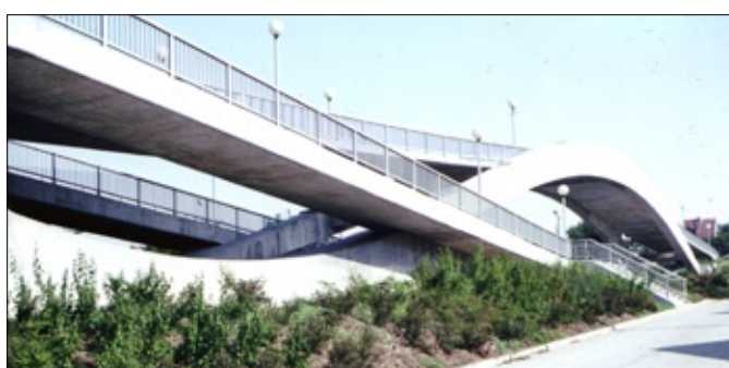
Ingenieurarbeit ist Teil des öffentlichen Lebens.
