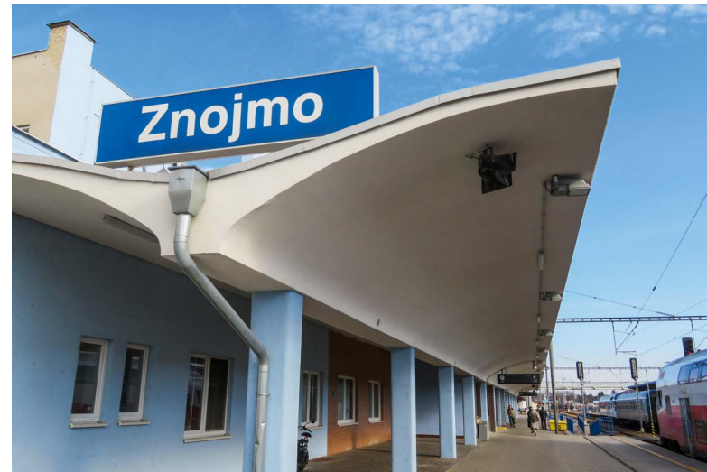
Bahnhof Znojmo; Architektur: Pavel Moravec, 1949–1951
